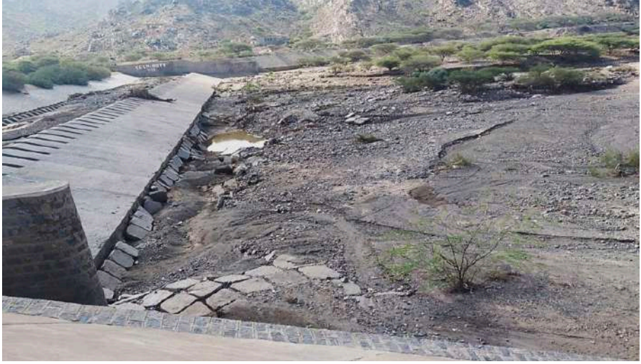
صورة توضح أضرار السيول ونحرها للتربة خلف سد سباء مديرية الحبيلين
