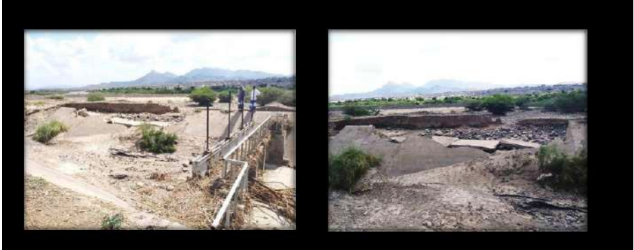
صورة توضح أضرار السيول ونحرها للتربة خلف سد سباء مديرية الحبيلين
